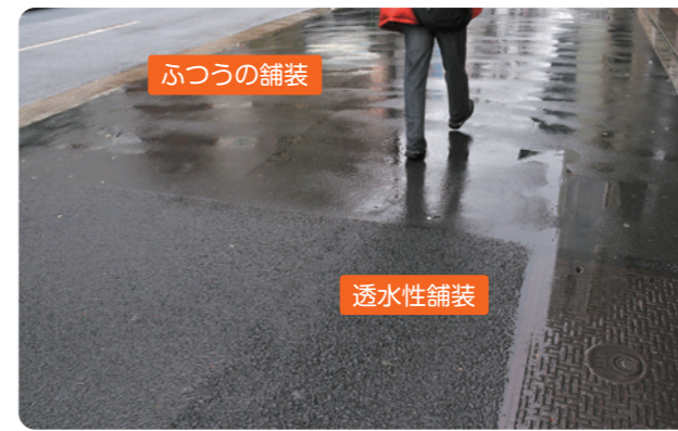
ふつうの舗装 透水性舗装 手前の舗装が透水性舗装。ふつうの舗装と比べて水たまりができません
