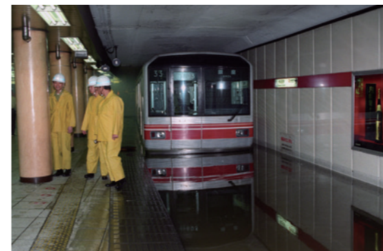
水がホームまであふれ、運転できなくなった地下鉄（平成5年8月27日。赤坂見付駅。写真提供：読売新聞社）
