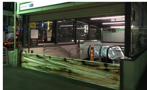
写真 止水板設置例
